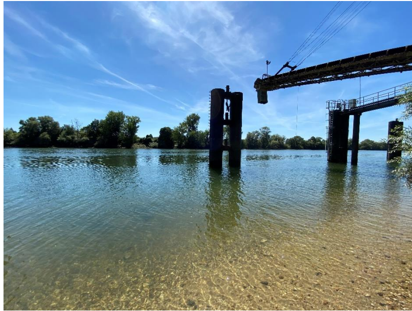
Figure 1 : Quai de Chargement déjà existant
